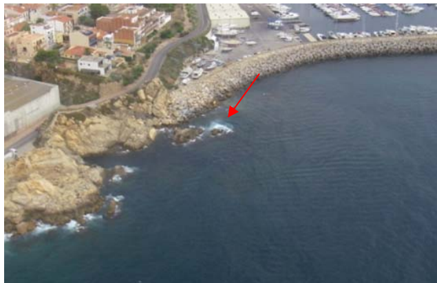
Taca d'aigües residuals marronoses al voltant de punt d'abocament del sobreexidor del Padró (20-07-2011)
