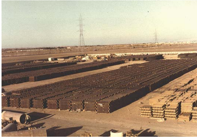
Acopio del contratista en Al AIN E.A.U.
