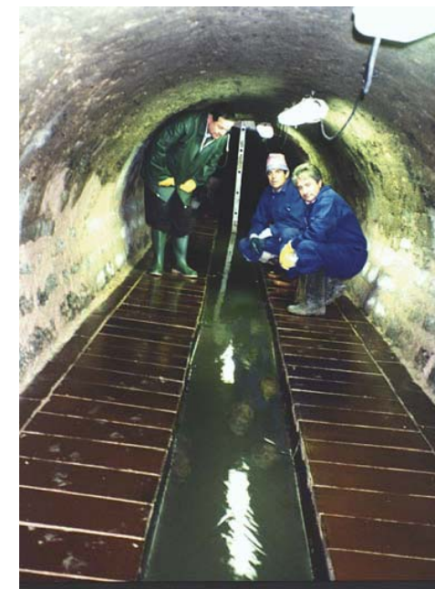
Burgos rehabilitación con plaquetas y medias secciones
