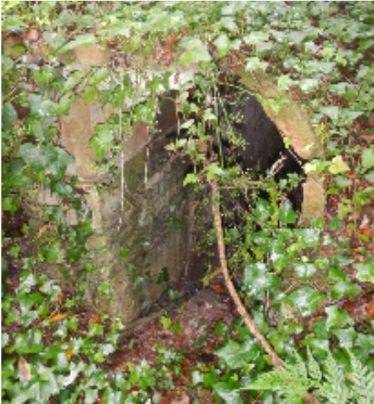
Foto 2: Mina d'aigua dins l'àmbit del PPU, en la zona inundable de la riera de Llavaneres (Font: MCA Consultors i assoc.).
