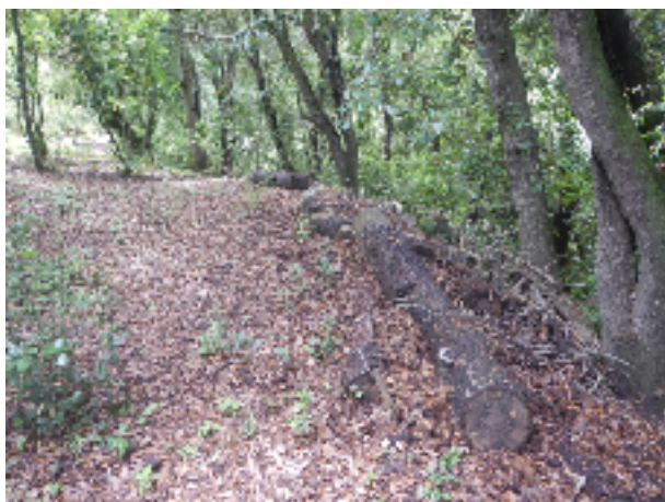
Foto 14: Estabilització de talusos amb troncs tallats al NW de l'àmbit (Font: MCA Consultors i associats).
