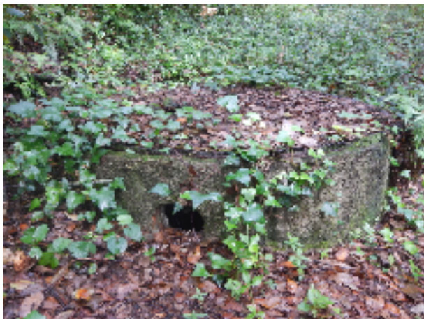
Foto 22: Registre de la xarxa de clavagueram que passa pel marge dret de la riera de Llavaneres (Font: MCA Consultors i associats).
