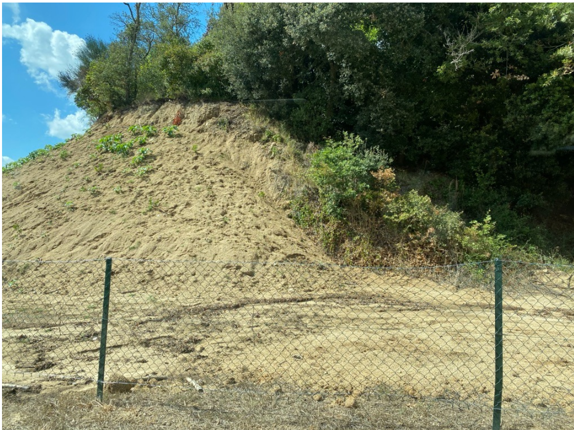
Talud restituído de zona pista multiusos – acceso rodado.
