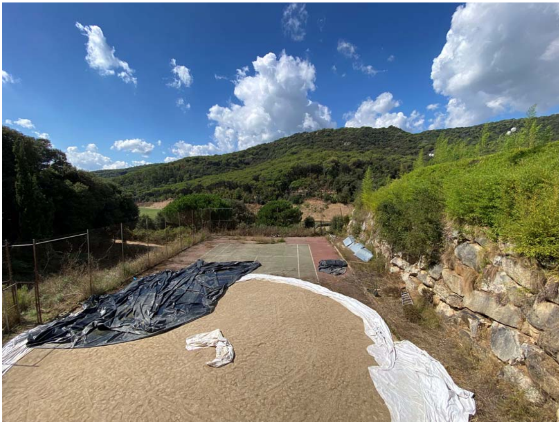
Desmontaje de depósito antiguo, zona pista de tennis.
