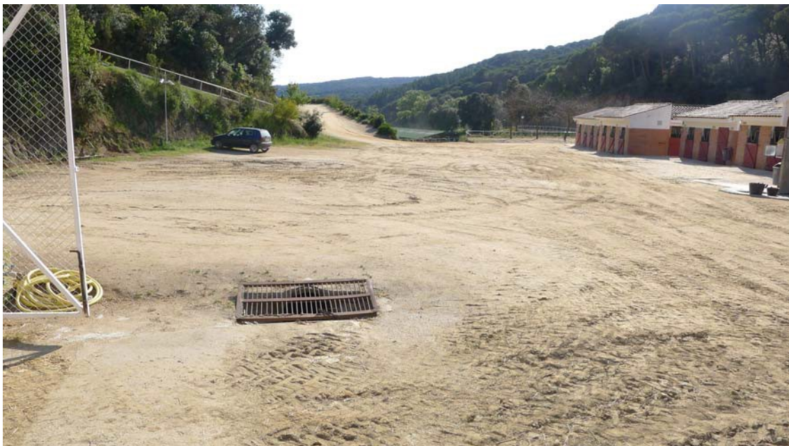
Sumideros de canalización de la riera.
