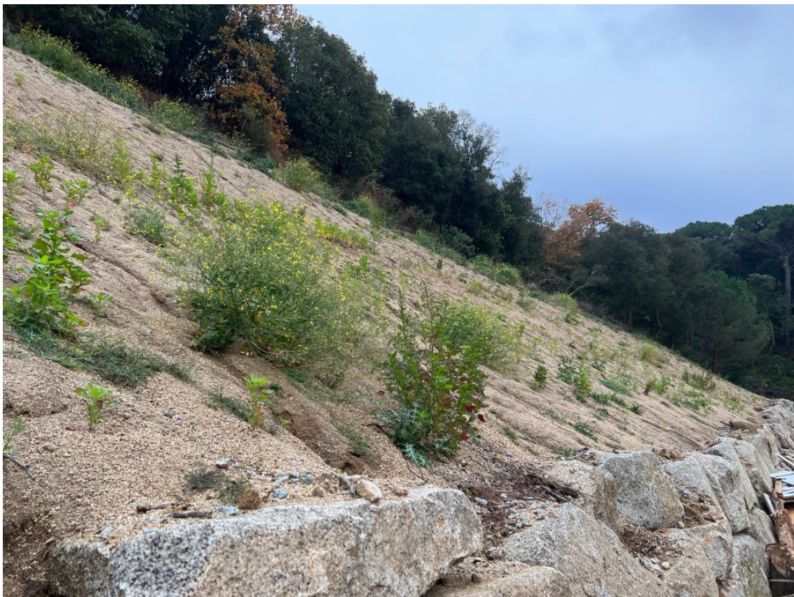
Talud restituído zona Sede social
