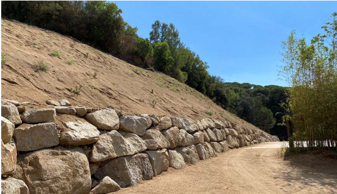
Talud restituído zona Sede social
