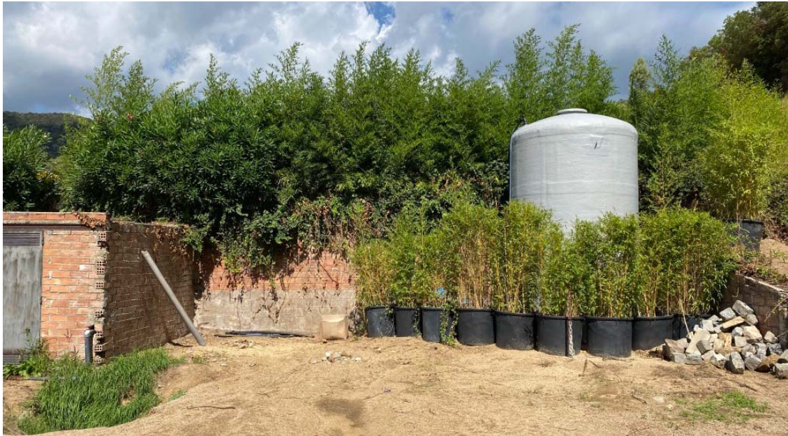
Nuevo depósito de agua.
