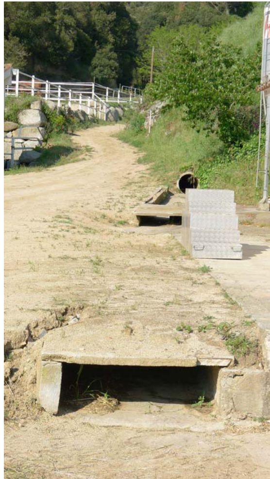
Canalización de la riera
