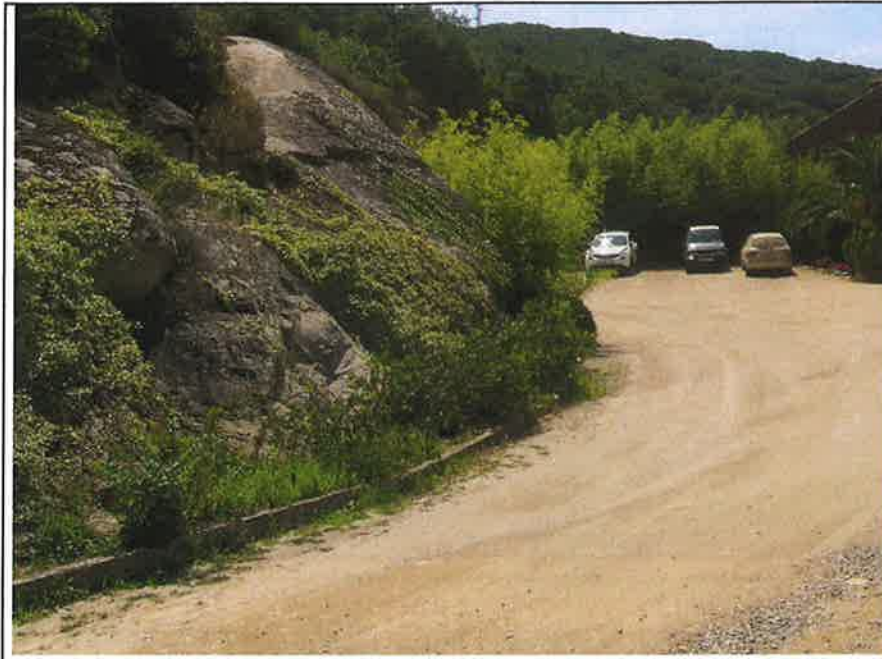
Cuneta de peu en baixada conca 3
