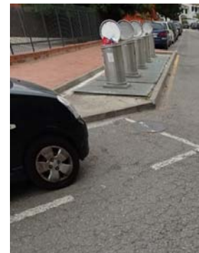
DEMOLICIÓ CONTENIDORS SOTERRATS
