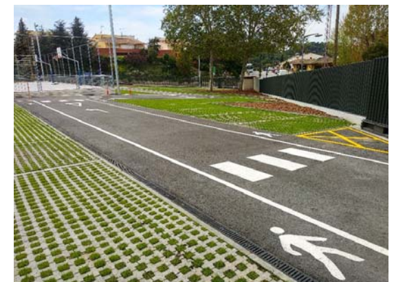
NOUS PAVIMENT TIPUS TRAMA EN ELS APARCAMENTS
