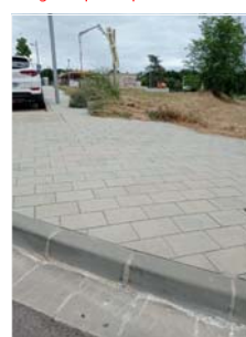
PAVIMENT TIPUS VULCANO dimensions 30 x 20 x 6 cm, de color gris top-complet bisellada
