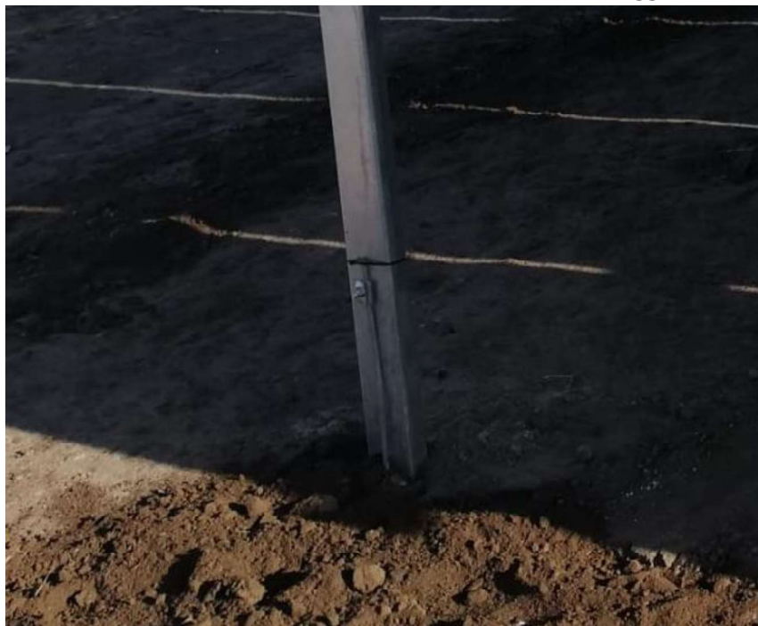
Ilustración 26 Conexión a tierra
