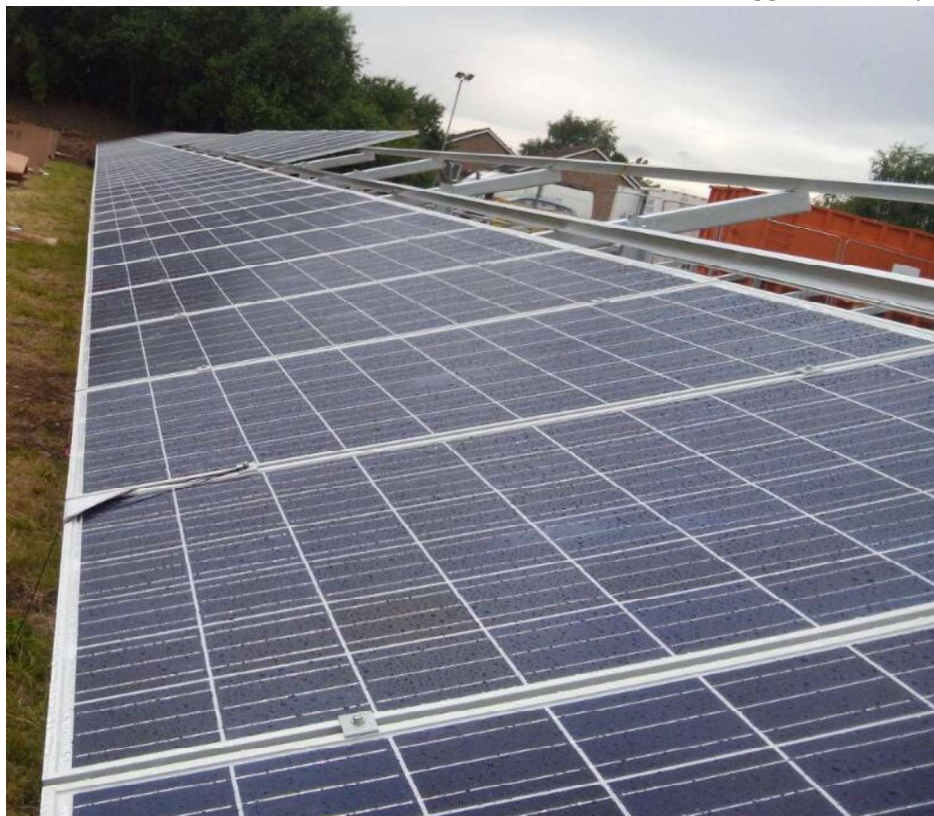
Ilustración 22 Mesa parcialmente montada
