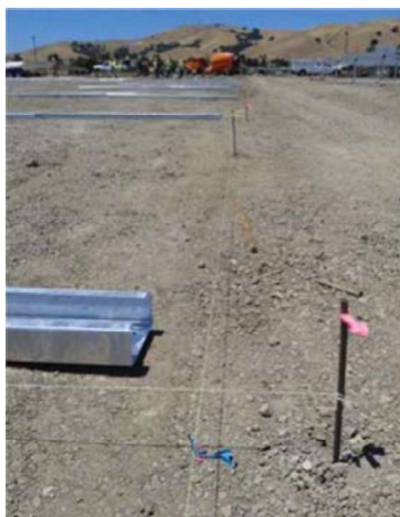
Ilustración 8 Replanteo de hincadas
