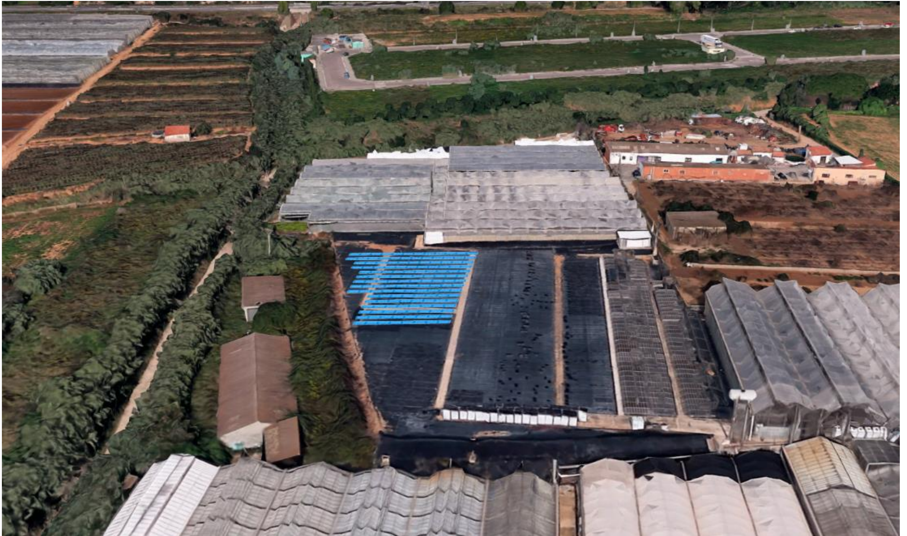
Figura 7. Vista d'ocell de la instal·lació solar projectada (els mòduls es representen amb un blau intens per facilitar-ne la contextualització, però realment tindran un color fosc similar al de la malla existent)
