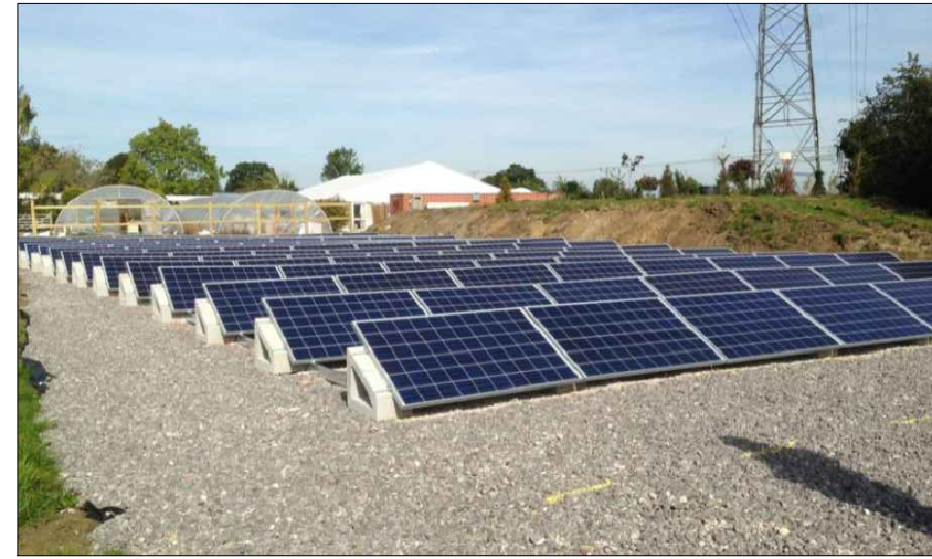
Sistema d'ancoratge autoportant (Font: SolarBloc)
