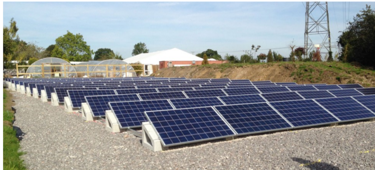
Imatge 3 .- Detall de suports posats sobre terreny (Font: SolarBloc)
