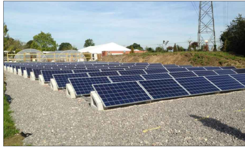
Sistema d'ancoratge autoportant (Font: SolarBloc)
