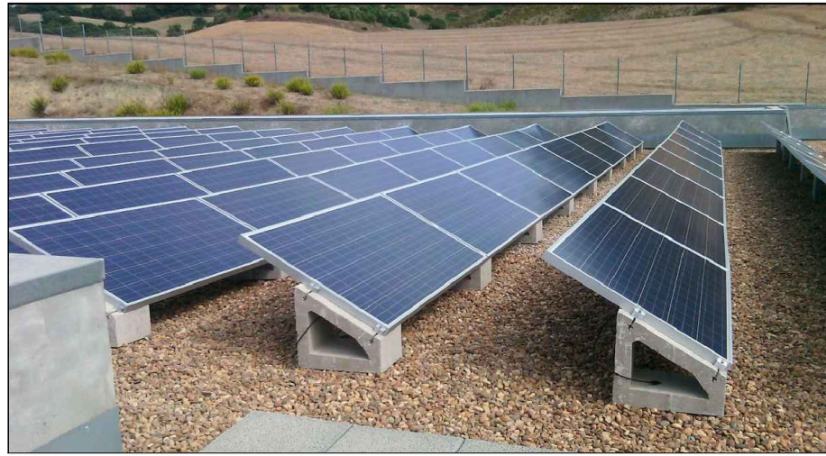
Sistema d'ancoratge autoportant (Font: SolarBloc)
