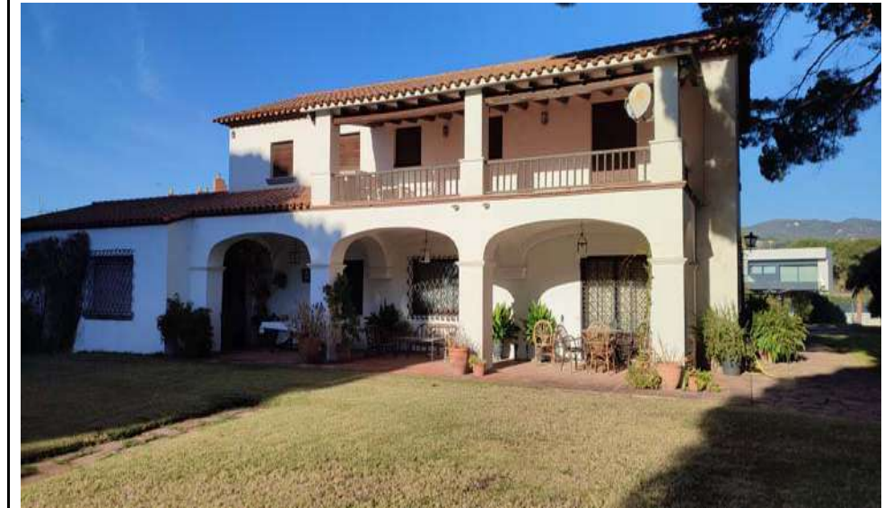
Foto 2: A.P.1: Vista general de la casa principal
