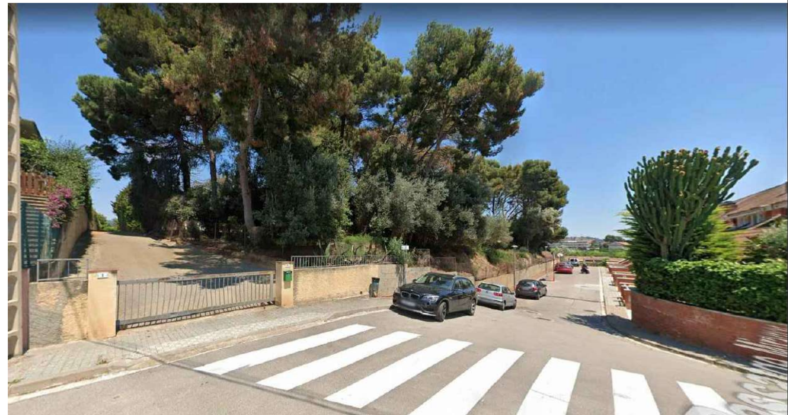
Detall cantonada Sud des de Passatge Miramar
