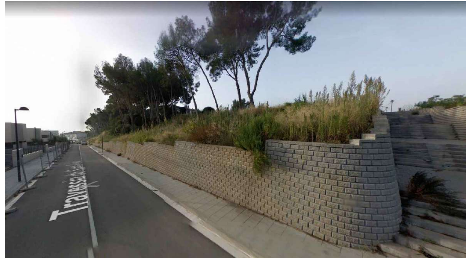
Detall cantonada Nord des de Travesia Sant Pere
