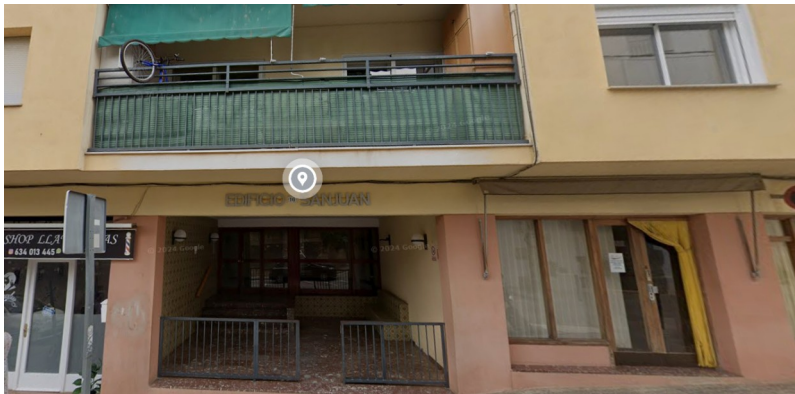
Façana de l'edifici al carrer Sant Joan, 16
