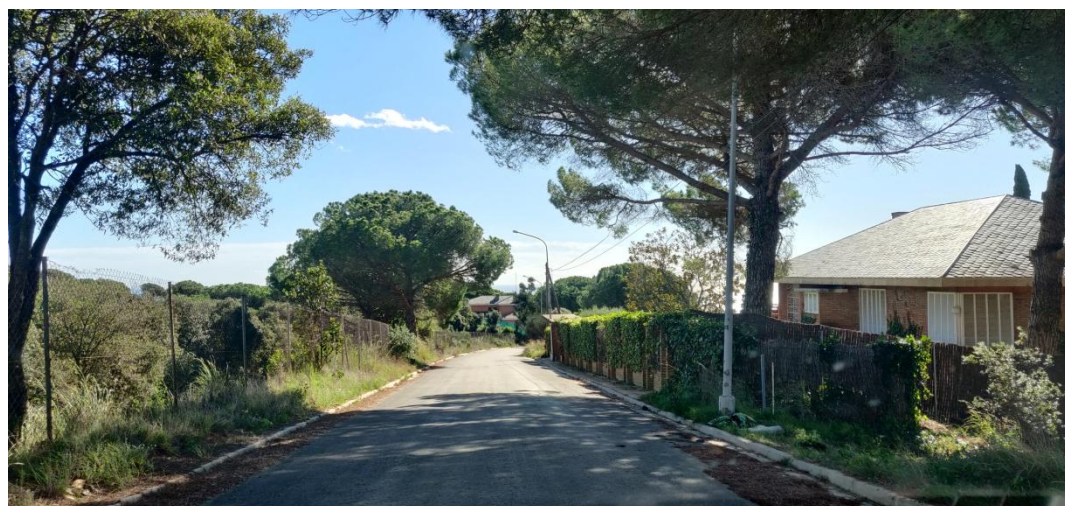
Figura 22 Imatge de l'Avinguda de La Cornisa des de la darrera casa del sector est. S'observen les vorades perimetrals, sense vorera, l'asfaltat del vial, la xarxa elèctrica i de telefonia aèria i els punts de llum amb bàculs metàl·lics. Font: fotografia pròpia; octubre de 2023
