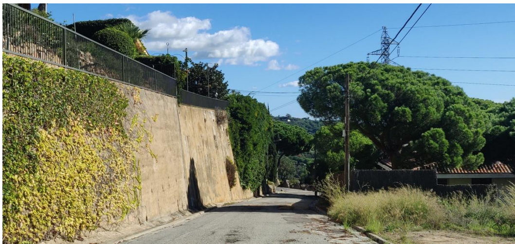
Figura 19 Avinguda de La Cornisa a la part central del tram inicial de la urbanització. Al fons es pot observar la torre de suport de la línia aèria d'alta tensió que travessa el sector. Font: fotografia pròpia; octubre de 2023
