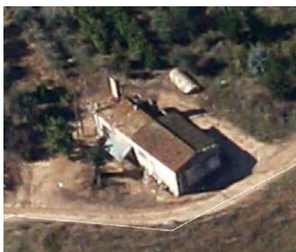
Construcció agrícola parcel·la 20.
