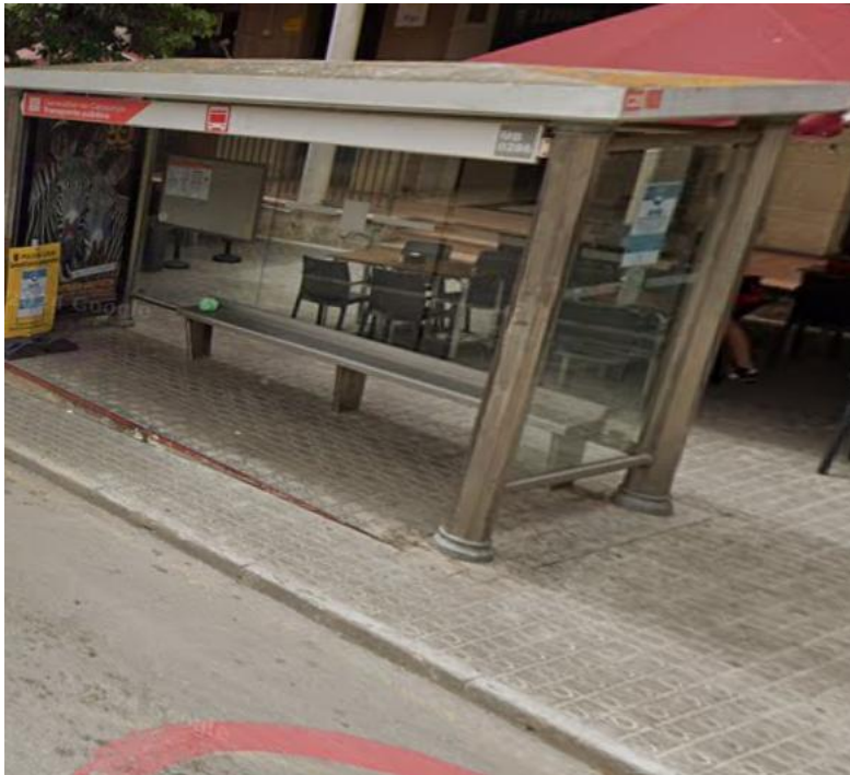
Marquesina de l'Avinguda Catalunya Font: Google Street View. Captura de la imatge: juny de 2024
