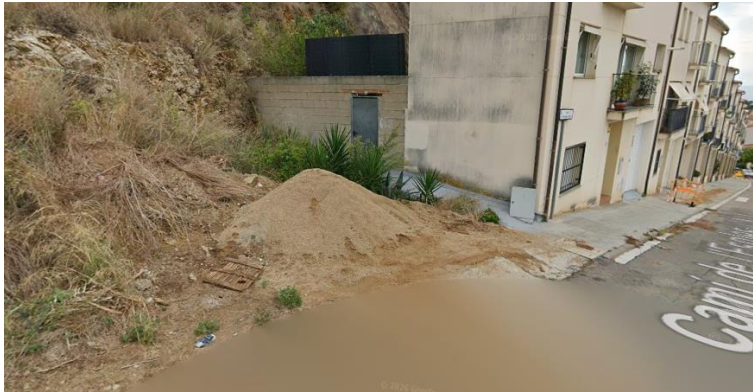
Punt amb acumulació de brutícia al Camí de l'Església Antiga, 36. Font: Google Street View.
