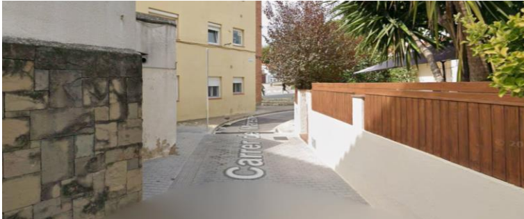
Manca d'il·luminació a la corba situada a l'alçada 1 del carrer Maresme
