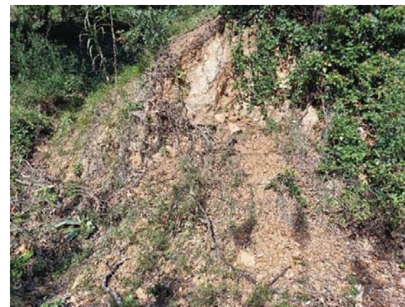
Fotografies índex 9. Massís rocallós amb talussos de desmunt on s'hi donen processos de despeniments i lliscaments. Carrer del Montseny
