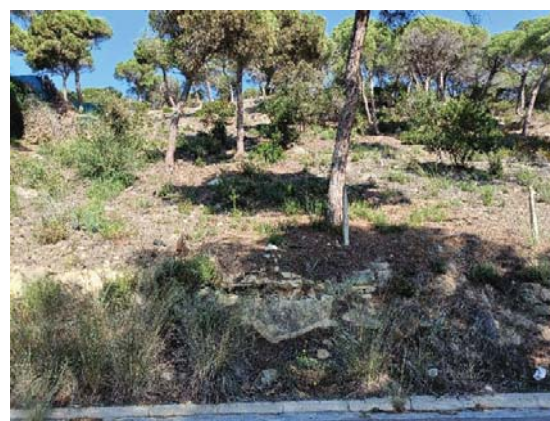
Fotografies indicati 3. Talussos de desmunt de carrer amb afloraments de sòls d'alteració de la roca i roca. Caiguda de blocs i lliscaments de magnitud petita. Avinguda de la Cornisa
