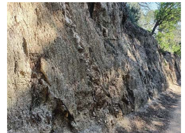
Fotografies índex 12. Talussos de desmunt de fins a 3 metres amb petites esclavissades, en tram final de l'avinguda de la Cornisa. Zona no urbanitzada en el límit del parc natural.
