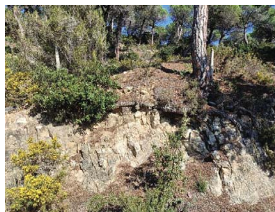
Fotografies indicati 3. Talussos de desmunt de carrer amb afloraments de sòls d'alteració de la roca i roca. Caiguda de blocs i lliscaments de magnitud petita. Avinguda de la Cornisa
