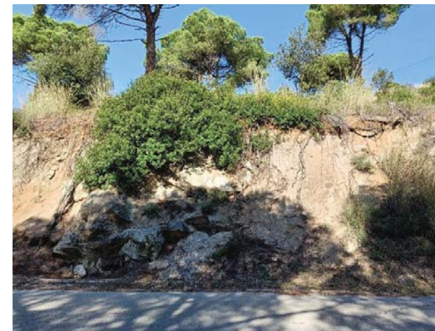
Fotografia indicatiu 1. Talús de desmunt en sòls d'alteració de la roca. Caiguda de blocs i lliscaments de magnitud petita. Avinguda de la Cornisa.
