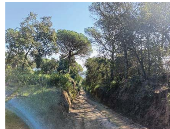
Fotografies índex 12. Talussos de desmunt de fins a 3 metres amb petites esclavissades, en tram final de l'avinguda de la Cornisa. Zona no urbanitzada en el límit del parc natural.
