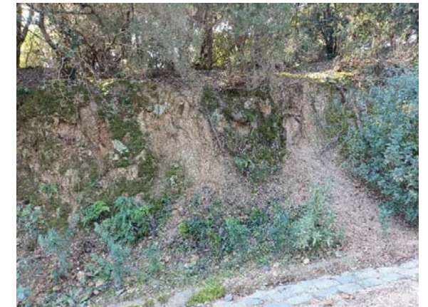
Fotografies índex 10. Talussos de desmunt de fins a 3 metres amb petites esclavissades, en el marge nord del tram final de l'avinguda de la Cornisa.
