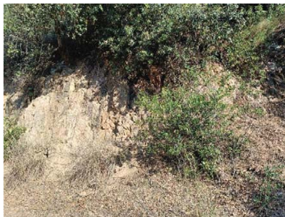
Fotografies índex 9. Massís rocallós amb talussos de desmunt on s'hi donen processos de despeniments i lliscaments. Carrer del Montseny
