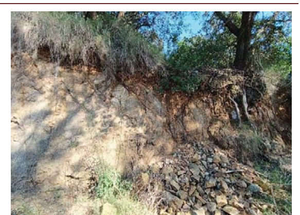
Fotografies indicati 6. Vista del tram inicial del carrer Canigó amb talussos de desmunt amb processos d'esllavissades. S'observen blocs de desprendiments acumulats al peu del talús, fins a dos metres del peu.
