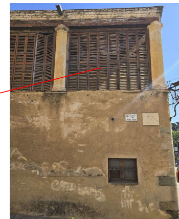
REHABILITACIÓ DE FAÇANA I RESTAURACIÓ DEL TANCAMENT DE LLIBRET
