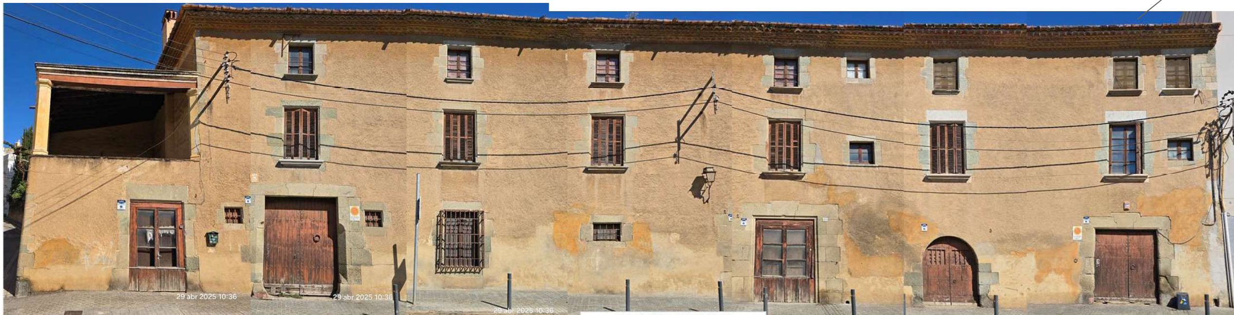
FAÇANA AVDA. CATALUNYA, 24
