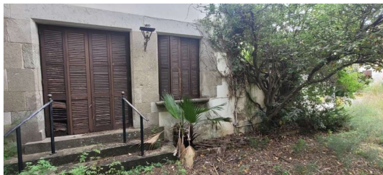
Detall fusteria exterior
