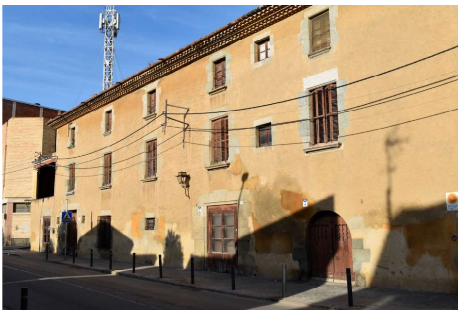
Detall façana principal avinguda Catalunya 24
