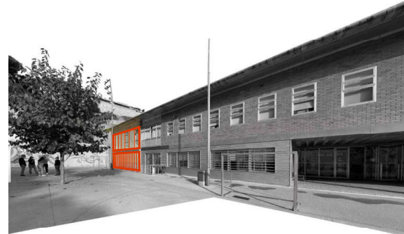
IMATGE 02/ FAÇANA, ENDERROCS
