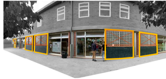
IMATGE 01/ FAÇANA. ESTAT ACTUAL.
