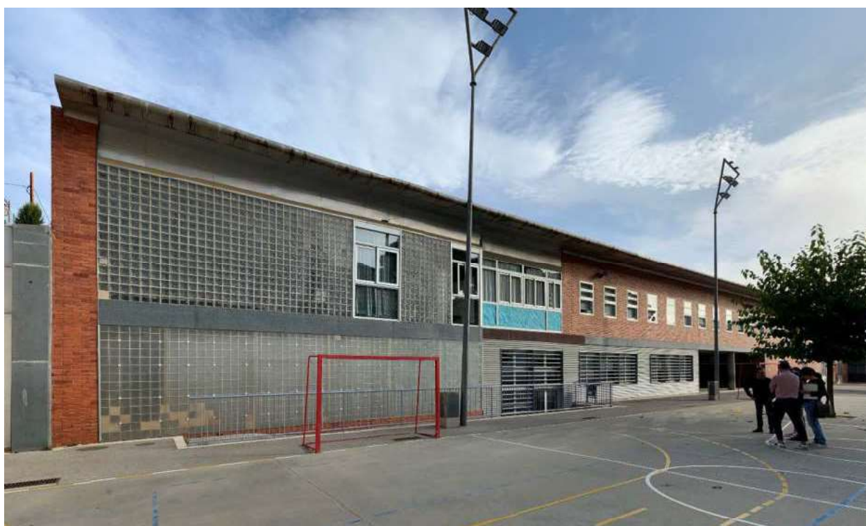
Figura 1./ Estat actual de la Zona A, Façana Sud.
