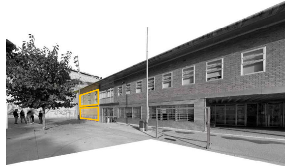
IMATGE 02/ FAÇANA, ENDERROCS
