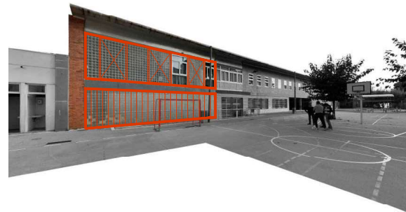
IMATGE 01/ FAÇANA, ENDERROCS
