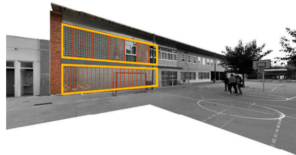
IMATGE 01/ FAÇANA. ENDERROCS
