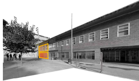
IMATGE 02/ FAÇANA. ENDERROCS
