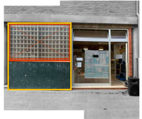
IMATGE 02/ FAÇANA. ESTAT ACTUAL.
