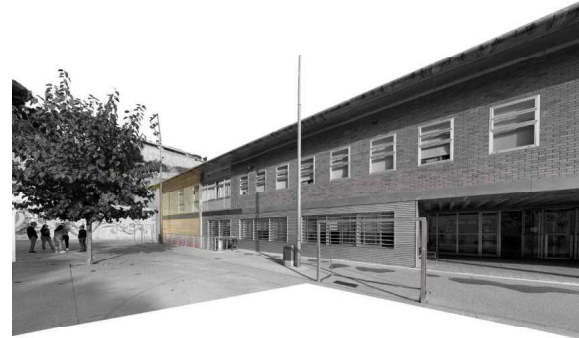
IMATGE 02/ FAÇANA. ESTAT ACTUAL
