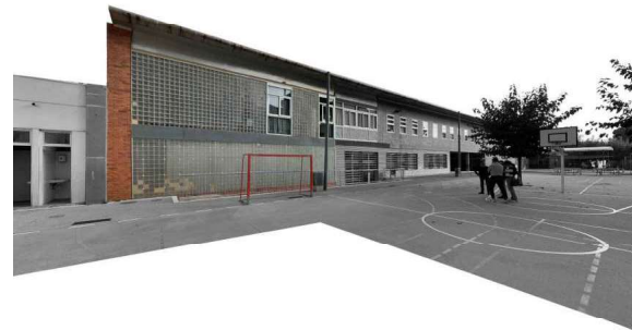
IMATGE 01/ FAÇANA. ESTAT ACTUAL
