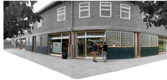
IMATGE 01/ FAÇANA. ESTAT ACTUAL.
