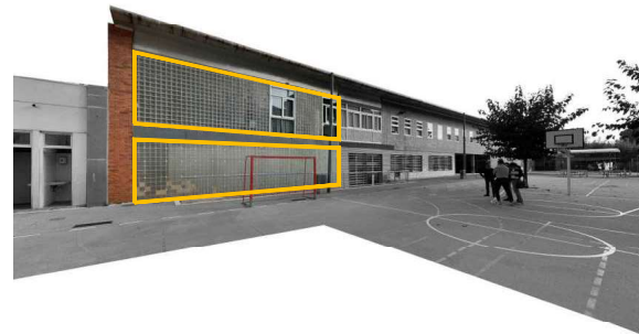
IMATGE 01/ FAÇANA, ENDERROCS
