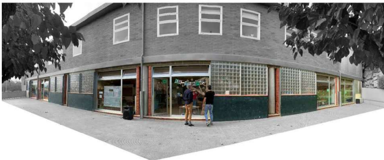
Figura 2./ Estat actual de la Zona B, Façana Nord.
