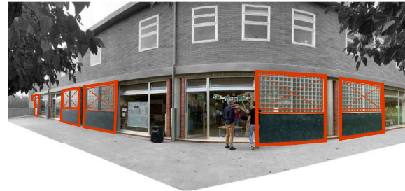
IMATGE 01/ FAÇANA. ESTAT ACTUAL.
