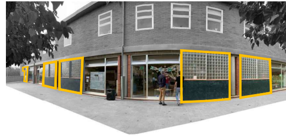
IMATGE 01/ FAÇANA. ESTAT ACTUAL.
