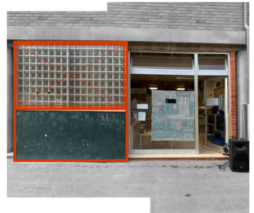
IMATGE 02/ FAÇANA. ESTAT ACTUAL.
