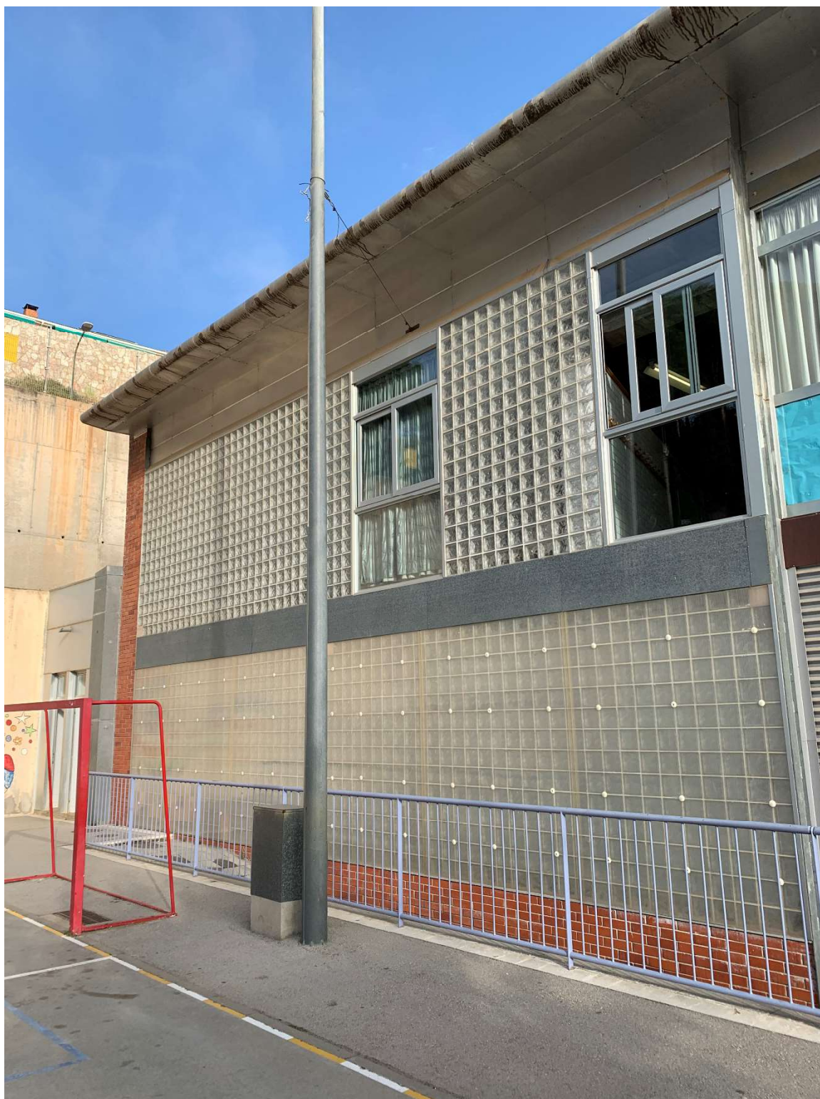
Imatge 04; Façana Sud.
