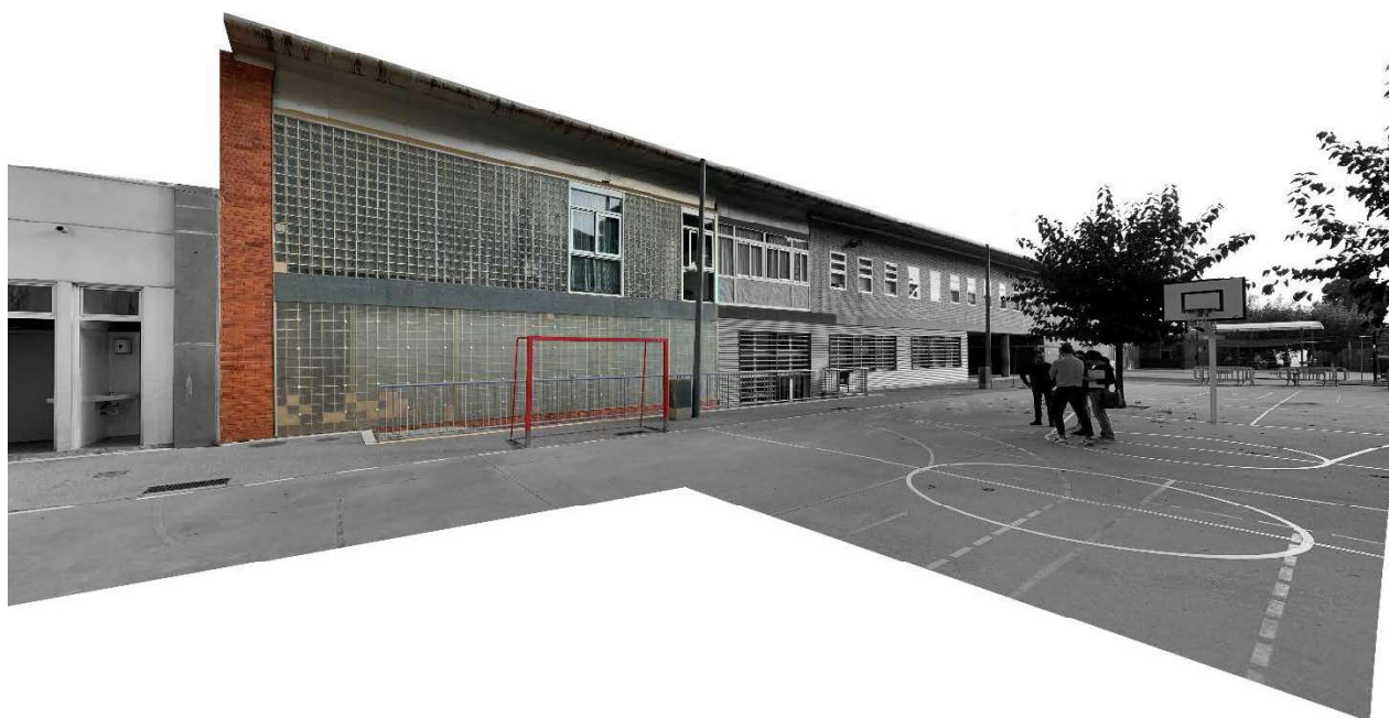
Imatge 03; Façana Sud
